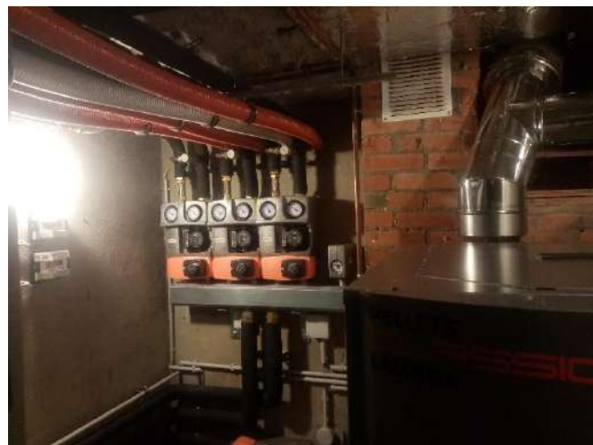
Chaudière mise en place dans la chaufferie de l'école
