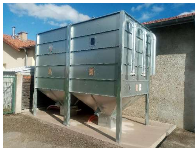
Silo de granulés de bois – 10 tonnes
