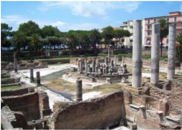
Temple de Sérapis, à Pouzzoles. Les traces sur les colonnes, jusqu'à une hauteur de 6,50 mètres au-dessus du niveau actuel, correspondent à l'enfoncement maximal atteint au X ème siècle.
